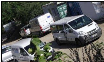
Auf der Baustelle ist viel los.
